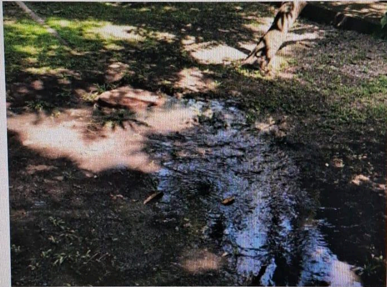
Figura 17 – Refluxo do esgoto do Campus para dentro da área da colônia de macacos rhesus.
